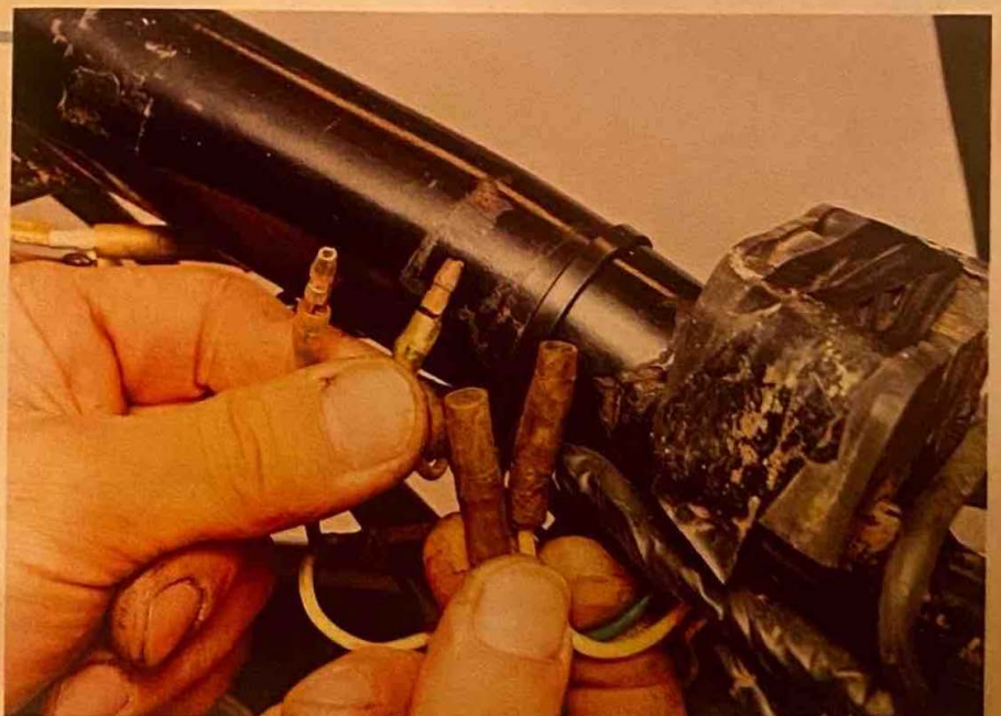
各種電装パーツが接続される部分は、腐が発生している場合は勿論のこと、ゴミやホコリが溜まっているだけでも導通が阻害される可能性がある。特に古くなった配線などは顕著なので、テスターを用いながら1個1個の疑いを潰していこう。ここで不具合が見つければ、それだけで問題が解決する可能性も少なくない
